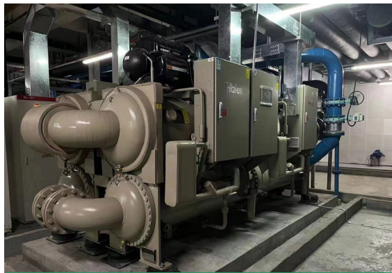
迭代升级原空调机组
